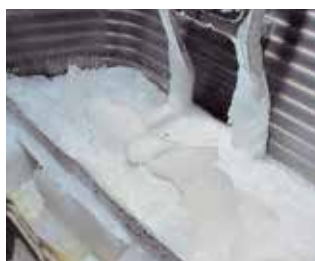
Обмерзання зовнішнього блоку без нагрівання піддону
