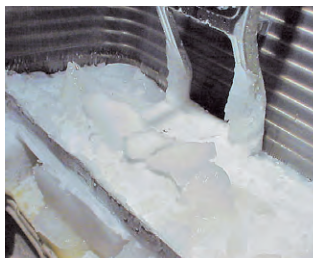
Обмерзання зовнішнього блоку без підігріву піддону
