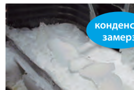
Без електричного нагрівача піддона
