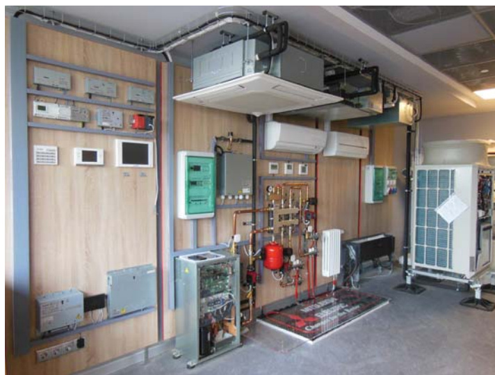
ДВУХТРУБНАЯ VRF-СИСТЕМА R2 С УТИЛИЗАЦИЕЙ ТЕПЛОТЫ
